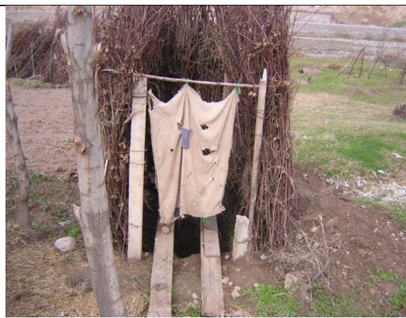
Mina a céu aberto sem laje / mina a céu aberto CÓDIGO 2
