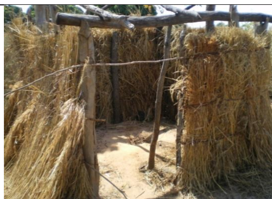
Latrina de fossa com laje (não lavável) CÓDIGO 3
