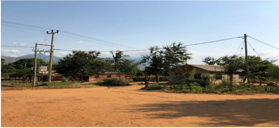
Fig: Exemplo de ligação à rede eléctrica nacional.
