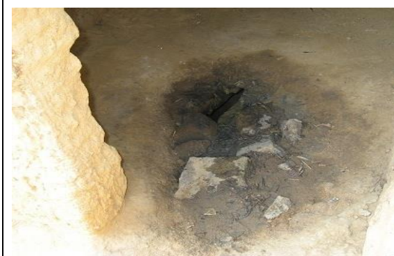
Latrina de fossa com laje (não lavável) CÓDIGO 3
