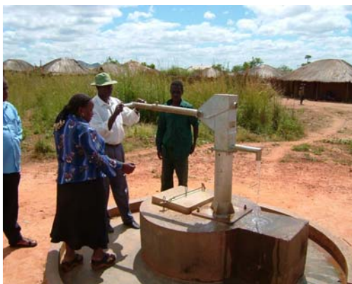
Poço protegido com bomba manual
